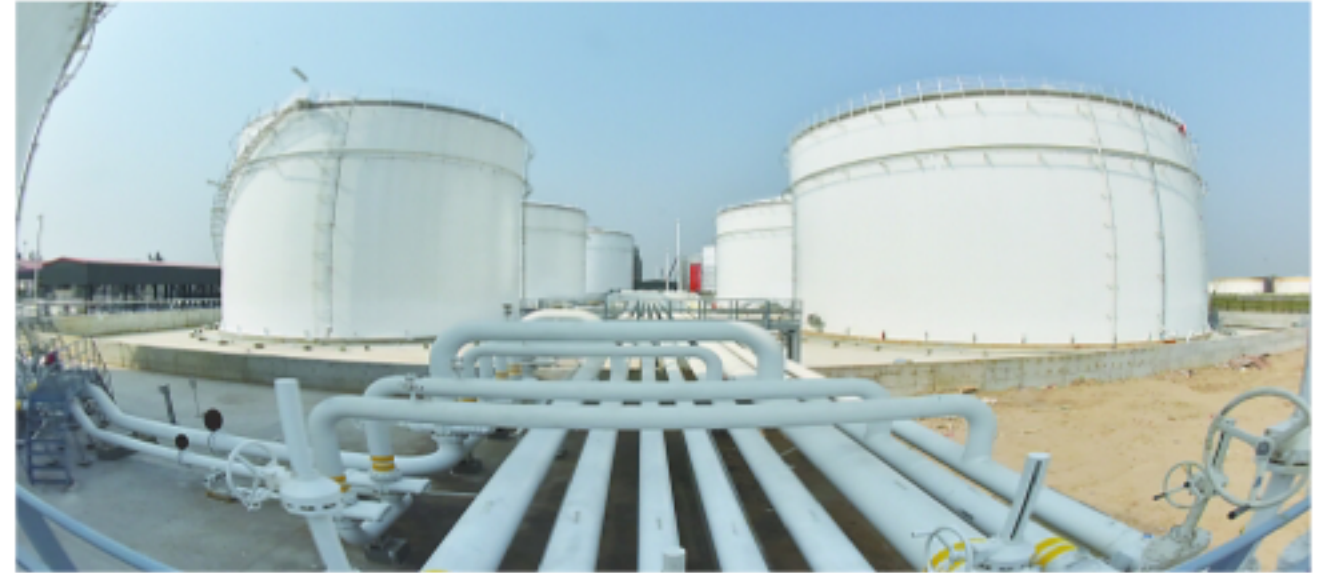
缅甸仰光油库项目
