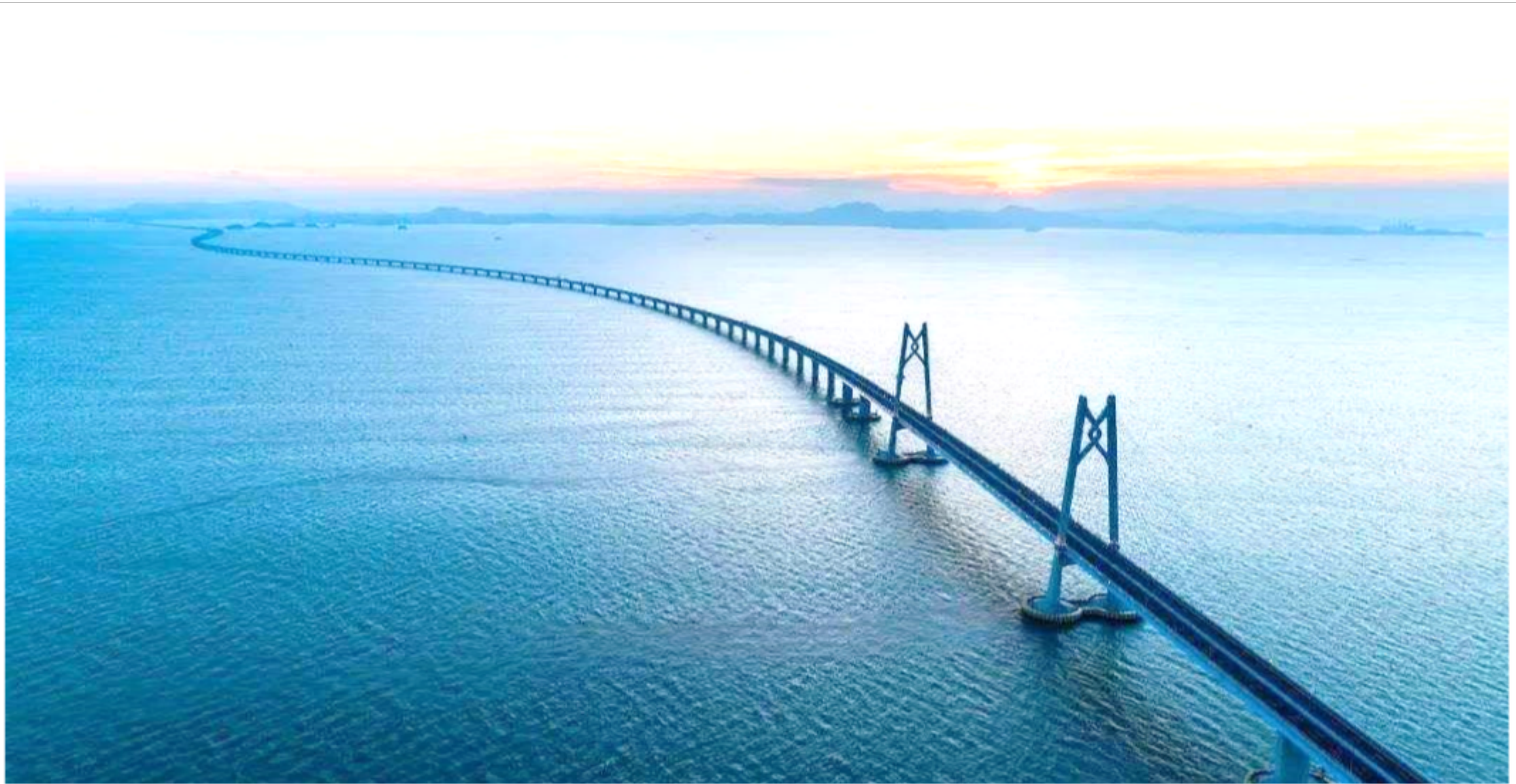
港珠澳大桥桩基
